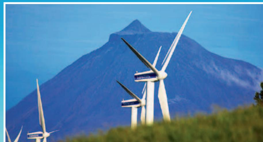
Le cinque turbine eoliche sull'isola di Faial nelle Azzorre (Atlantico) alimentano una microgrid autonoma che fornisce energia ai 15mila abitanti del luogo, altrimenti senza possibilità di connessione a una rete di alimentazione principale.
